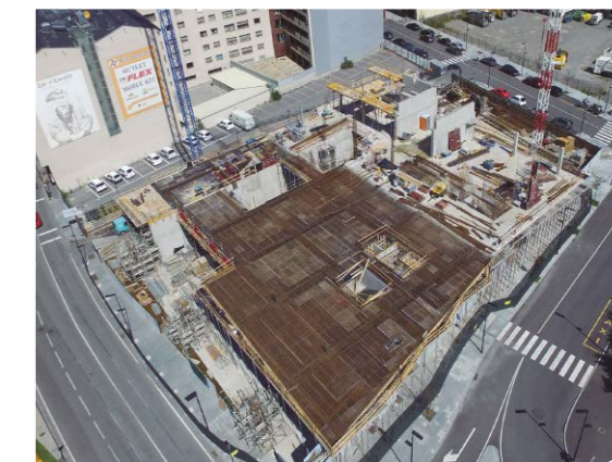
Nova Seu de la Justícia en construcció
